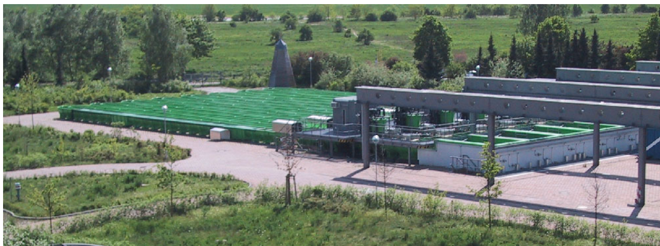
Abb. 1: Außenbereich des neuen Fließgewässer-Mesokosmos auf dem Versuchsfeld Marienfelde (Foto: M. Liess). Zusätzlich zu den je 8 Rinnen und Teichen im Außenbereich verfügt die Anlage über 8 weitere, identische 100m-Rinnen und 8 Teiche in einer Versuchshalle, in der Versuche unter kontrollierteren Bedingungen durchgeführt werden können
