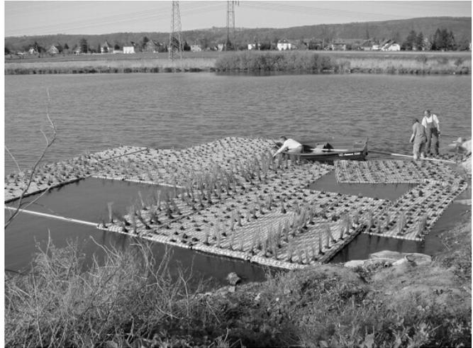
**Abbildung 3:** Der modulare Aufbau der schwimmenden textilen Pflanzeninseln erhöht die Strukturvielfalt und Handhabbarkeit.
