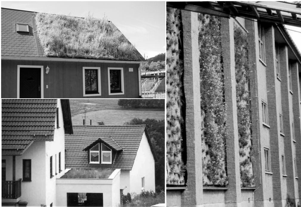
**Abbildung 1:** Steil-, Flachdach- und Fassadenbegrünung (Foto Bauhaus Dessau) mit Hilfe substratloser textiler Pflanzenträgermatten (REPOTEX) zur Niederschlagsretention.
