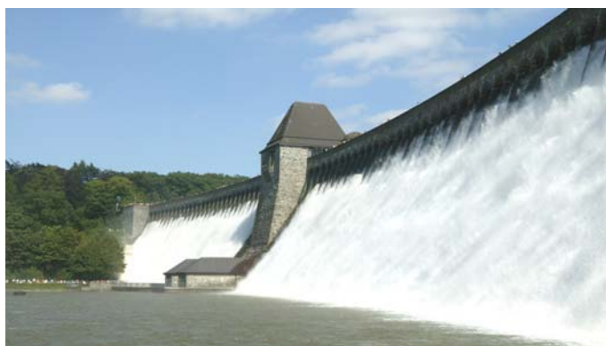
Abb. 5: Überlauf der Möhnetalsperre mit 64 m 3 /s am 11.8.2007
