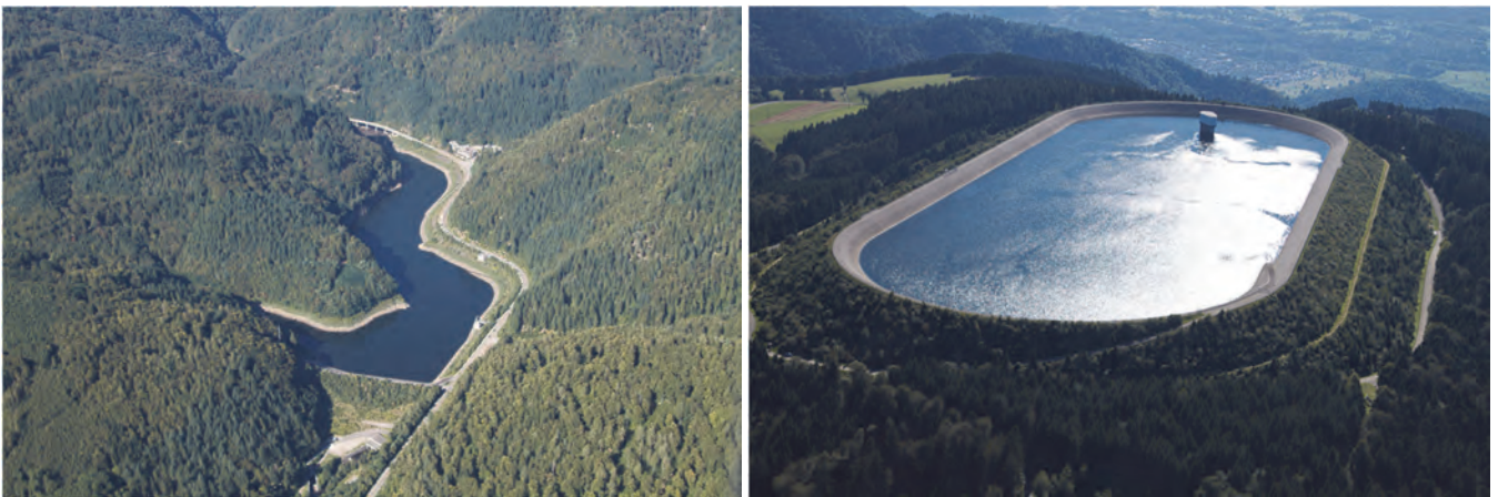
Abb. 2: Wehrabecken (links) und Hornbergbecken (rechts) als Beispiele für Unter- und Oberbecken. Die im Untersuchungsgebiet befindlichen Seen dienten zur Modelleichung.
