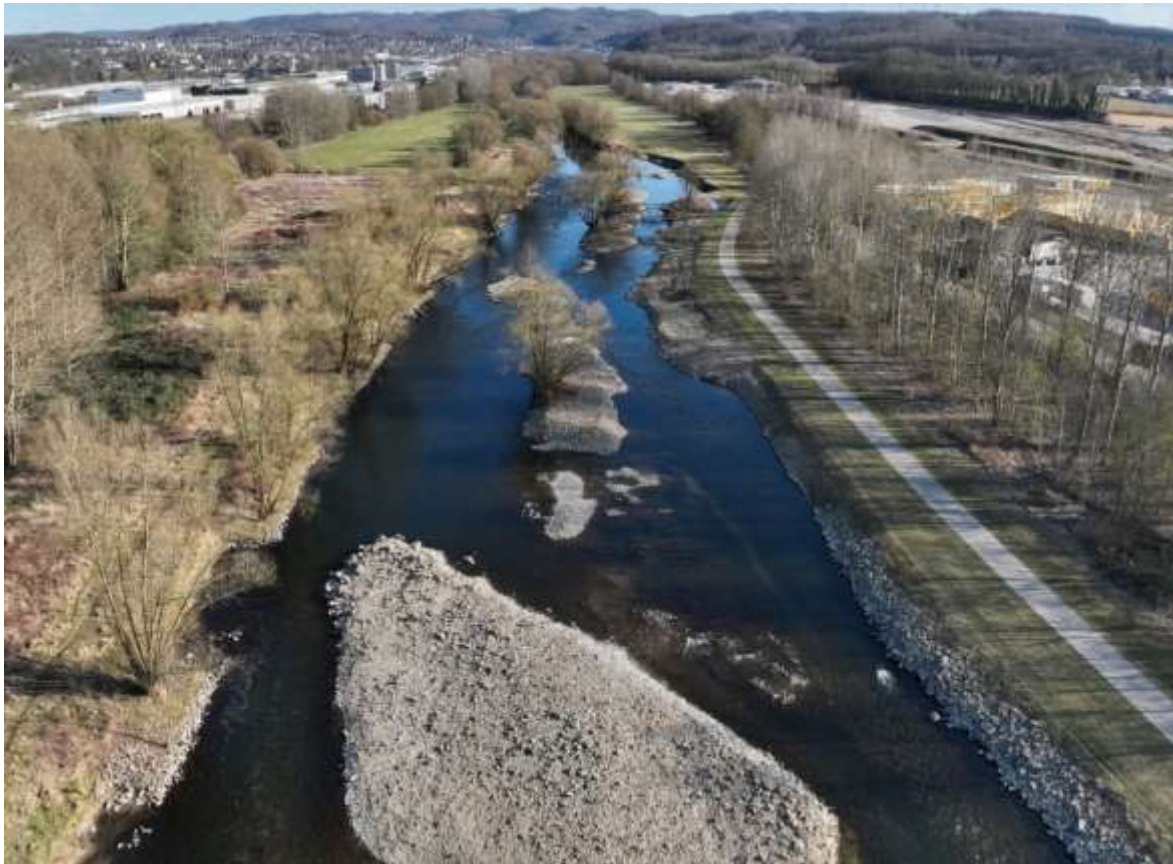
Abb. 12: Lenne 3.Bauabschnitt, Zustand am 20.03.2025; Foto: Die Gewässer-Experten, Siegburg
