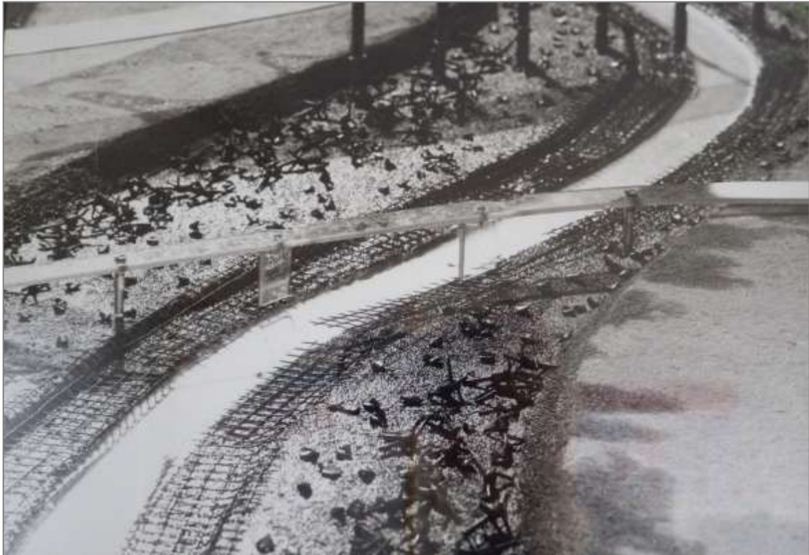
Abb. 3: Laborversuch zur Lenneverlegung in Hagen/Westfalen; STADT HAGEN (1972), Reproduktion: J. Drewenskus
