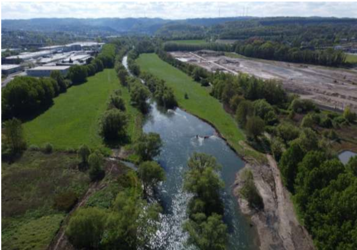
Abb. 11: Lenne 3. Bauabschnitt, Fertigstellung der Aufweitung, 4.6.2024; Foto: Biologische Station Umweltzentrum Hagen
