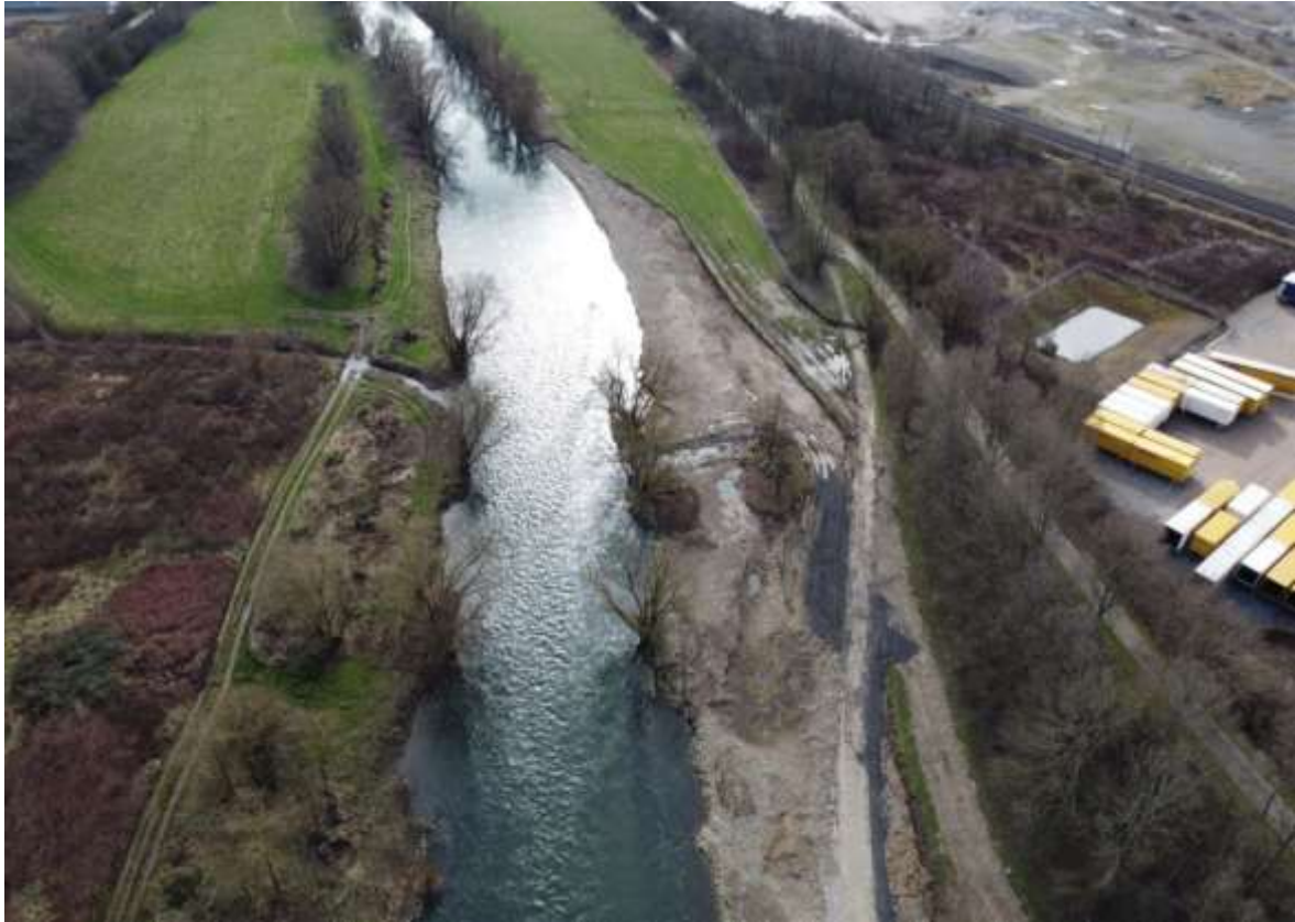
Abb. 10: Lenne 3. Bauabschnitt, Vorbereitung der Aufweitung, 23.04.2024; Foto: Biologische Station Umweltzentrum Hagen
