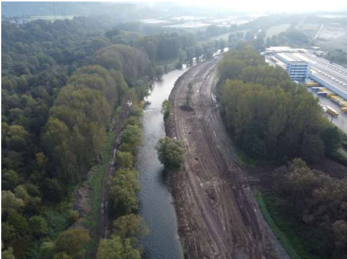
Abb. 8: Lenne 3.Bauabschnitt, Abtrag des Aue-Oberbodens, Stand der Bauarbeiten 17.10.2023; Foto: Biologische Station Umweltzentrum Hagen
