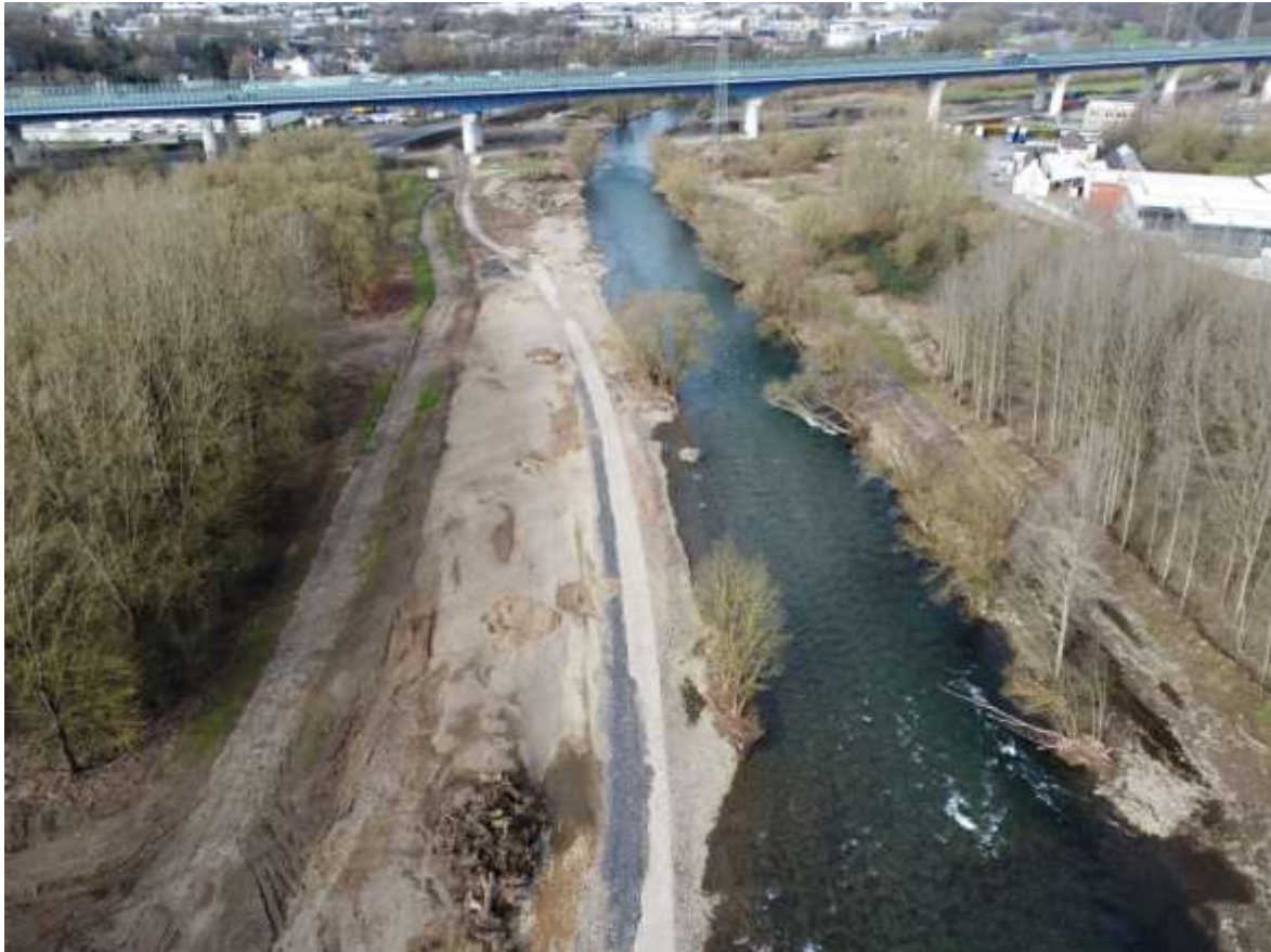
Abb. 9: Lenne 3. Bauabschnitt, in Fließrichtung, freigelegte Schotterflächen, 29.02.2024; Foto: Biologische Station Umweltzentrum Hagen
