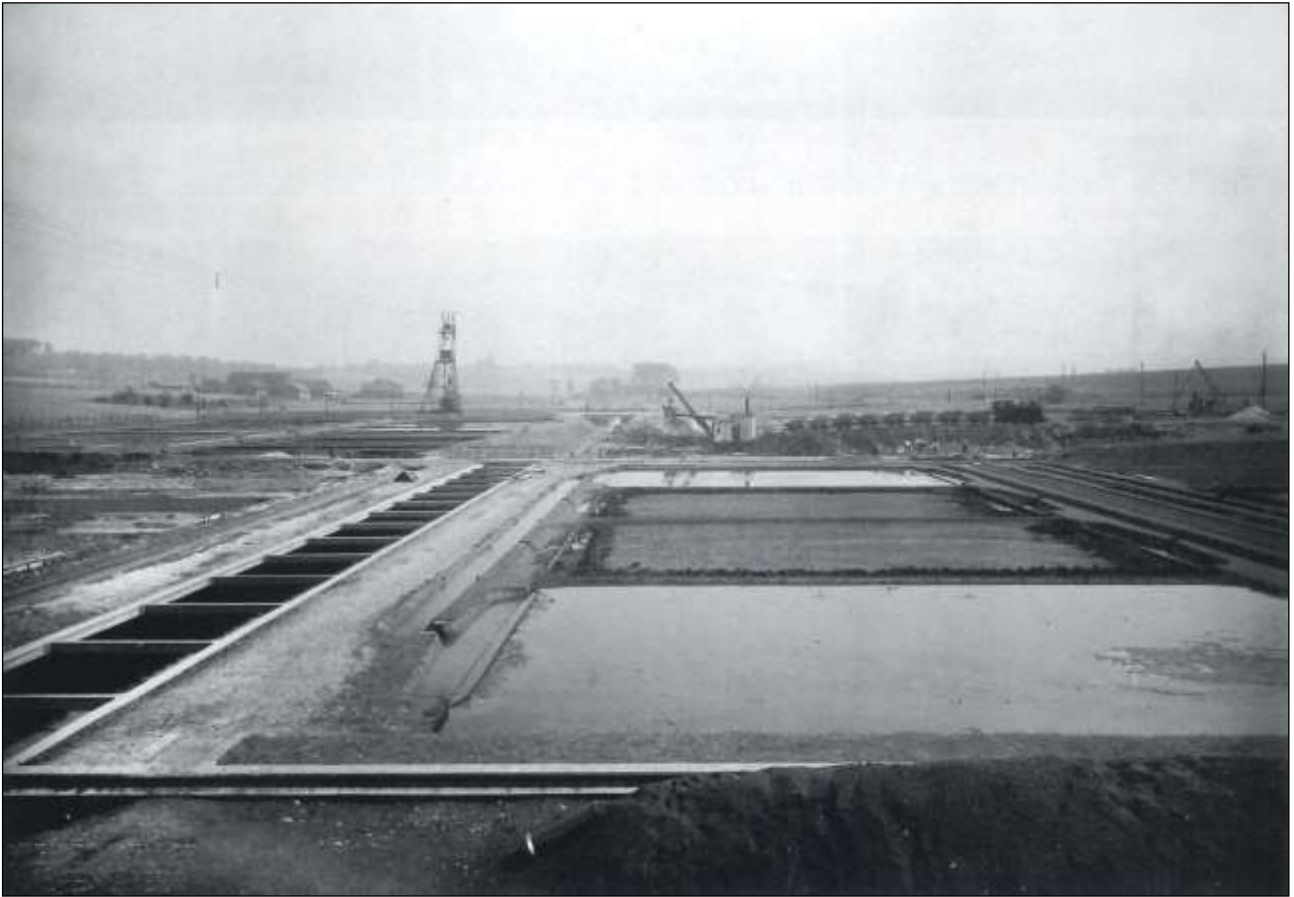
Abb. 5: Kläranlage Bochum-Oelbachtal um 1926, Oelbach (links) mit Kohleschlamm-Absetzbecken, Foto: Archiv Ruhrverband, Essen
