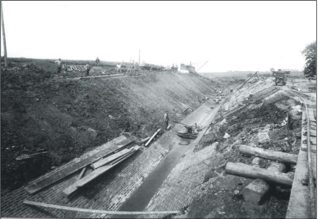
Abb. 4: Ausbauarbeiten am Oelbach um 1926, Foto: Archiv Ruhrverband, Essen
