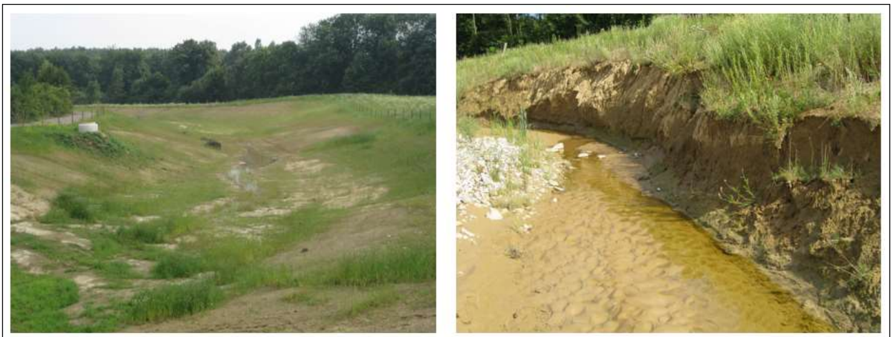
Abb. 10: Kirchharpener Bach, km 9,5; Gewässeroffenlegung und Neutrassierung, Foto links: J. Drewenskus (2015), Foto rechts: J. Drewenskus (2016)
