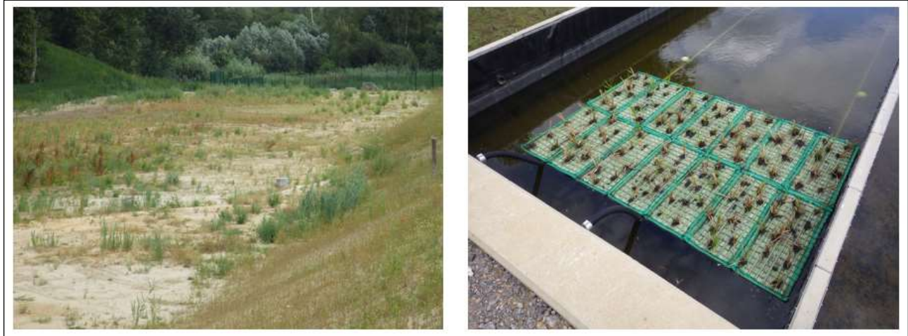
Abb. 11: Gerther Mühlenbach, km 11,8; Altlastensanierung mit Bachsohlenabdichtung (Foto links), Neubau Bioreaktor und Pflanzenkläranlage mit Kalmus ( Acorus calamus ) zur Grundwasserdekontamination (Foto rechts) Fotos: J. Drewenskus (2019)
