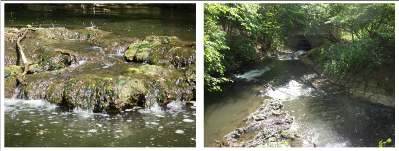
Abb. 8: Oelbach, Sinterbildung; km 7,5; über 600 m lange Verrohrung (DB u. A 43) bei km 7,4; Fotos: J. Drewenskus (2020)
