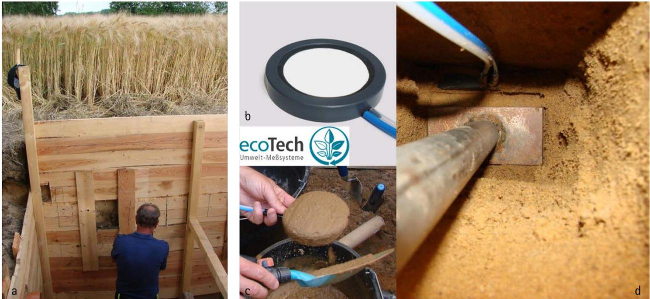
**Abb. 2: Erstellung eines Messfeldes: a )Einschalung der Baugrube, b) Keramische Saugplatte (Foto: ecoTech), c) Einschlämmen der Saugplatte, d Bindiger Einbau und Anschluss an die darüber gelegene Bodenmatrix.**
