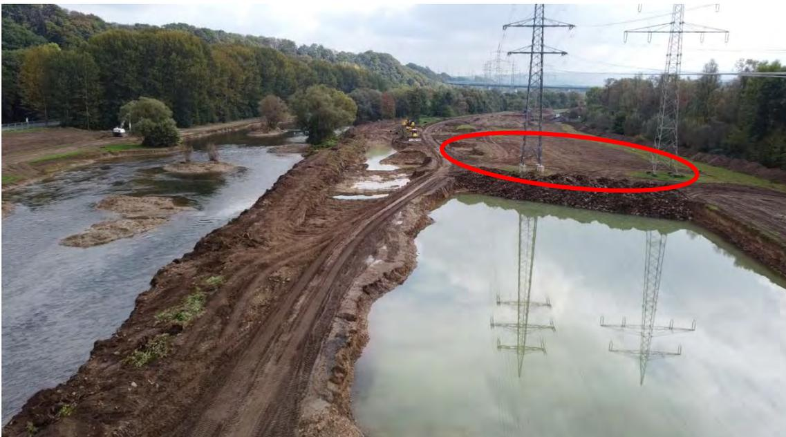
**Abb. 5: Lenne 1.BA, Detail Bodensiebung und Ablagerung von Boden zur Straßensicherung (rechts), 09.09.2020, Foto: Biologische Station Umweltzentrum Hagen.**
