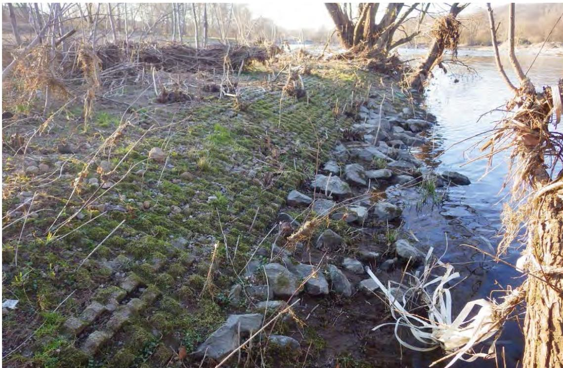
**Abb. 4: Lenne, Uferverbau mit Rasengitter- und Wasserbausteinsicherung, 27.07.2021, Foto: J. Drewenskus.**
