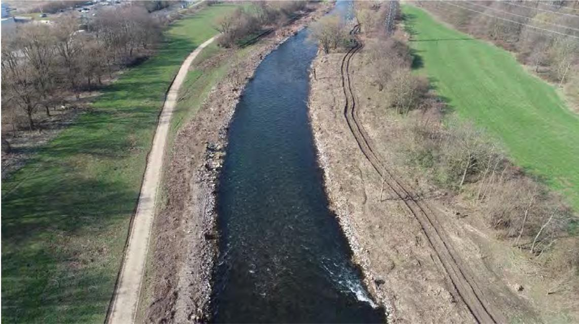
**Abb. 10: Lenne 2.BA; unmittelbar vor Maßnahmenbeginn mit bereits entfernten Ufergehölzen, Rasengittersteine (unten links) sowie Wasserbausteine (rechts) gut sichtbar, 24.03.2021, Foto: Biologische Station Umweltzentrum Hagen.**
