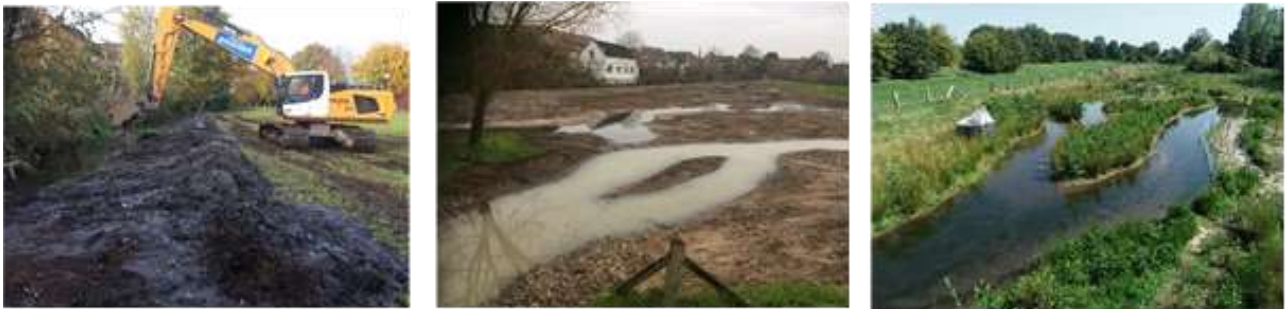
Abb. 1: Renaturierungsmaßnahme an der Alpschen Ley (links: Entschlammung des begradigten Altverlaufs; Mitte: Schaffung eines neuen gewässertypkonformen Gewässerverlaufs; rechts: Sukzession nach Maßnahmenumsetzung und Malaise-Falle für das Insektenmonitoring)
