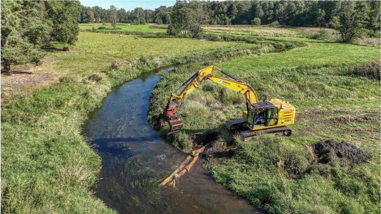
Abbildung 4: Einbau von Totholz in die Stepenitz. (Foto: Marko Bläsche)
