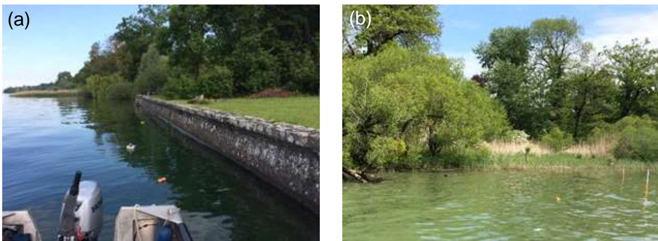
Abb. 2: (a) Mit Ufermauer bewehrter Uferabschnitt in Friedrichshafen. (FNSM-Test); UTM 32T 533984 5278016; 13.06.2019. Zu erkennen sind die beleuchtete Boje für den Drucksensor der Wellenmessungen sowie die orangefarbenen Bojen, die die Lage der Probenahme-positionen kennzeichnen. (b) Naturnaher Uferabschnitt in Friedrichshafen (FNSM-Referenz), UTM 32T 533815 5278071, 23.05.2019. Am Ufer ragt ein Sturzbaum (linker Bildrand: Weide, Salix sp.) in den See hinein. Fotos: © J. P. Armbruster.
